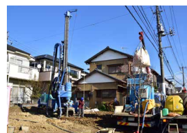
▲地盤改良工事
