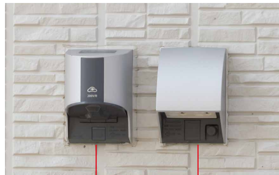
EV充電コンセント 屋外コンセント
