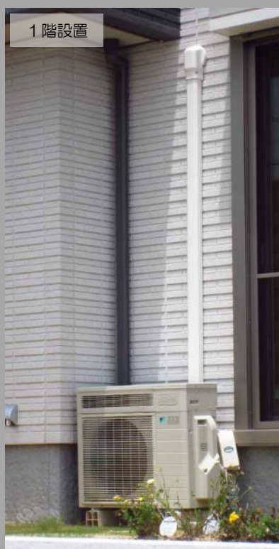
エアコン室外機（スリムダクト配管）
