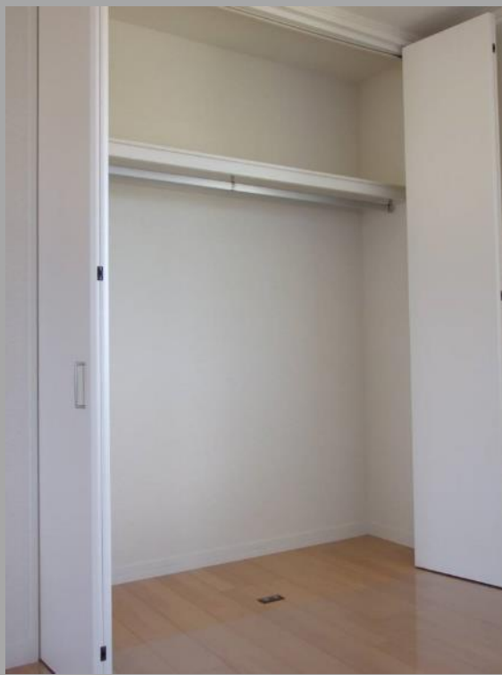
クローゼット2.0×0.6 ワイズ折戸 + パンセS枕棚(パイプ付)
