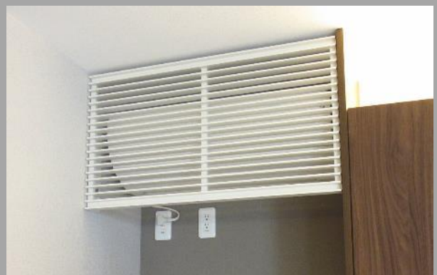
エアコン将来設置部 隠蔽配管カバー納め
