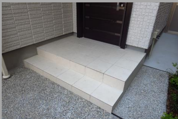
玄関ポーチ（300口タイル）
