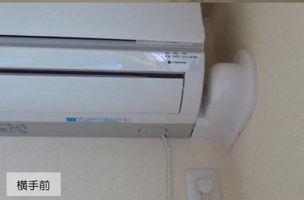
エアコン配管横抜き
