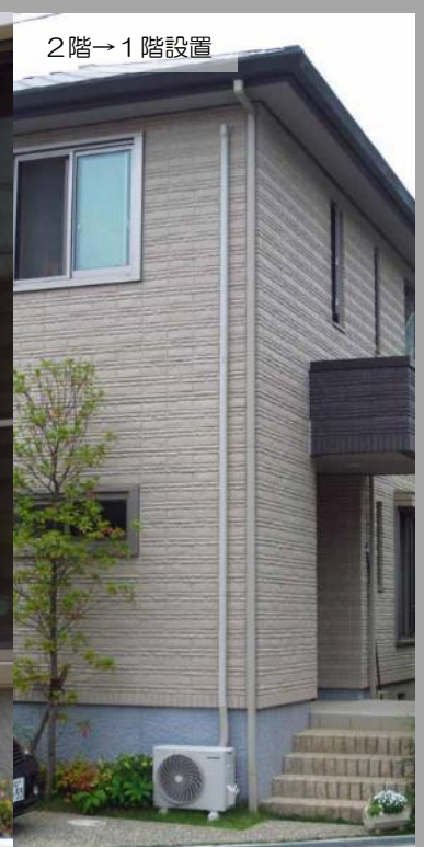
エアコン室外機（スリムダクト配管）
