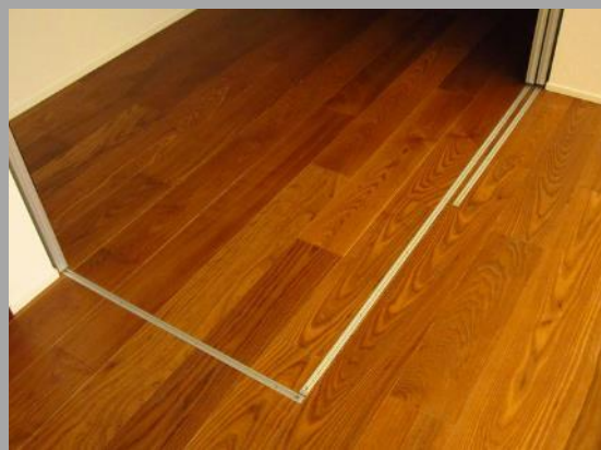
スクリーンパーティション レール・縦枠
