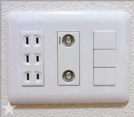
コンセント + TV端子 + 空配管(ブランク)
