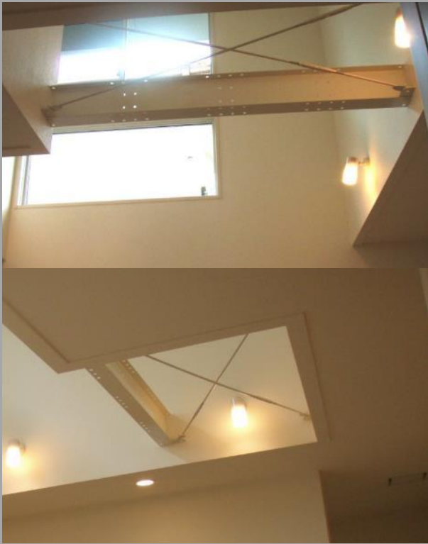
あらわし梁・あらわしブレース
