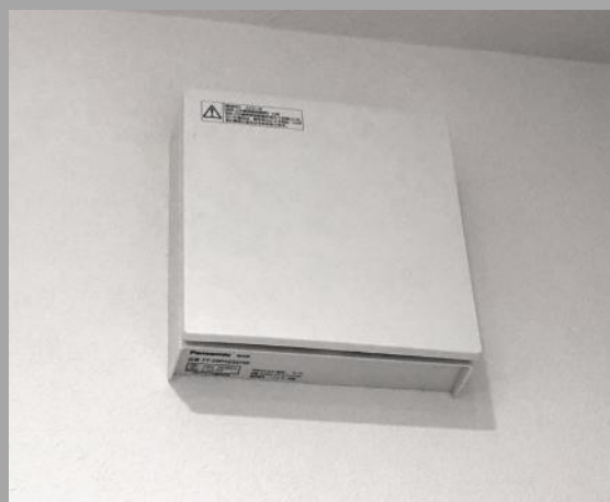
24時間換気個別排気ファン（FY-08PAE9SH）
