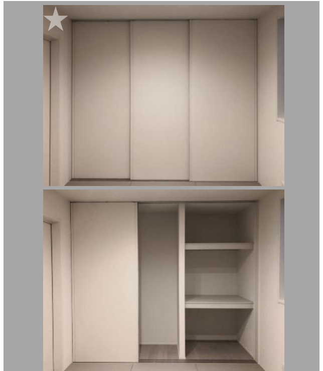
物入 3.0×1.0 スライディングウォール3枚引き違い+パンセS中段棚2段
