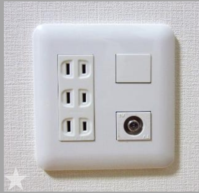
コンセント+ TV端子 + 空配管(ブランク)
