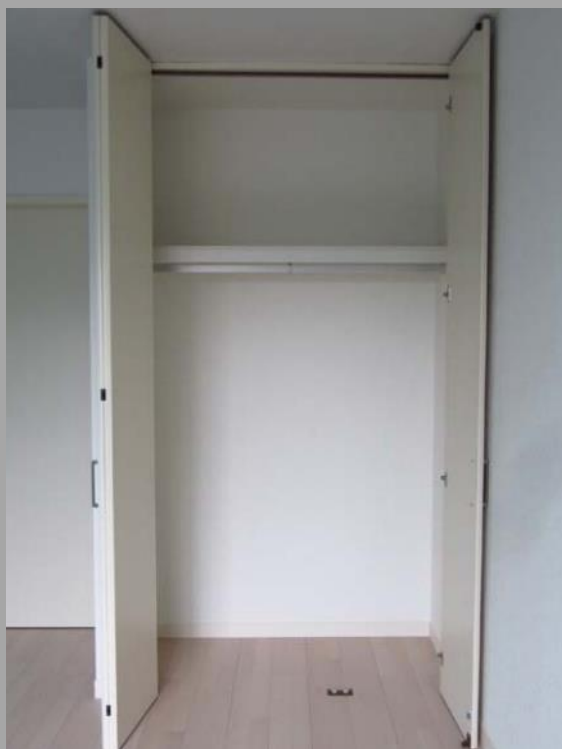
クローゼット1.5×1.0 ワイズ折戸 + パンセS枕段(パイプ付き)
